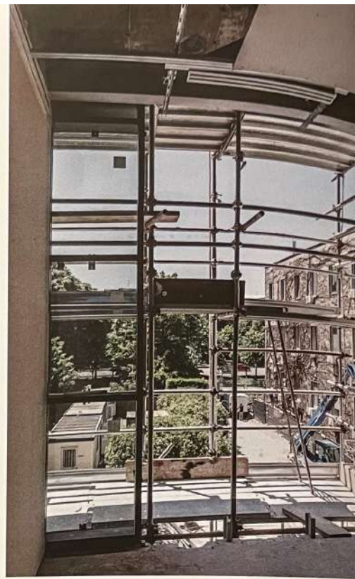
Opere di controsoffittatura del lungo corridoio distributivo nei vari piani
